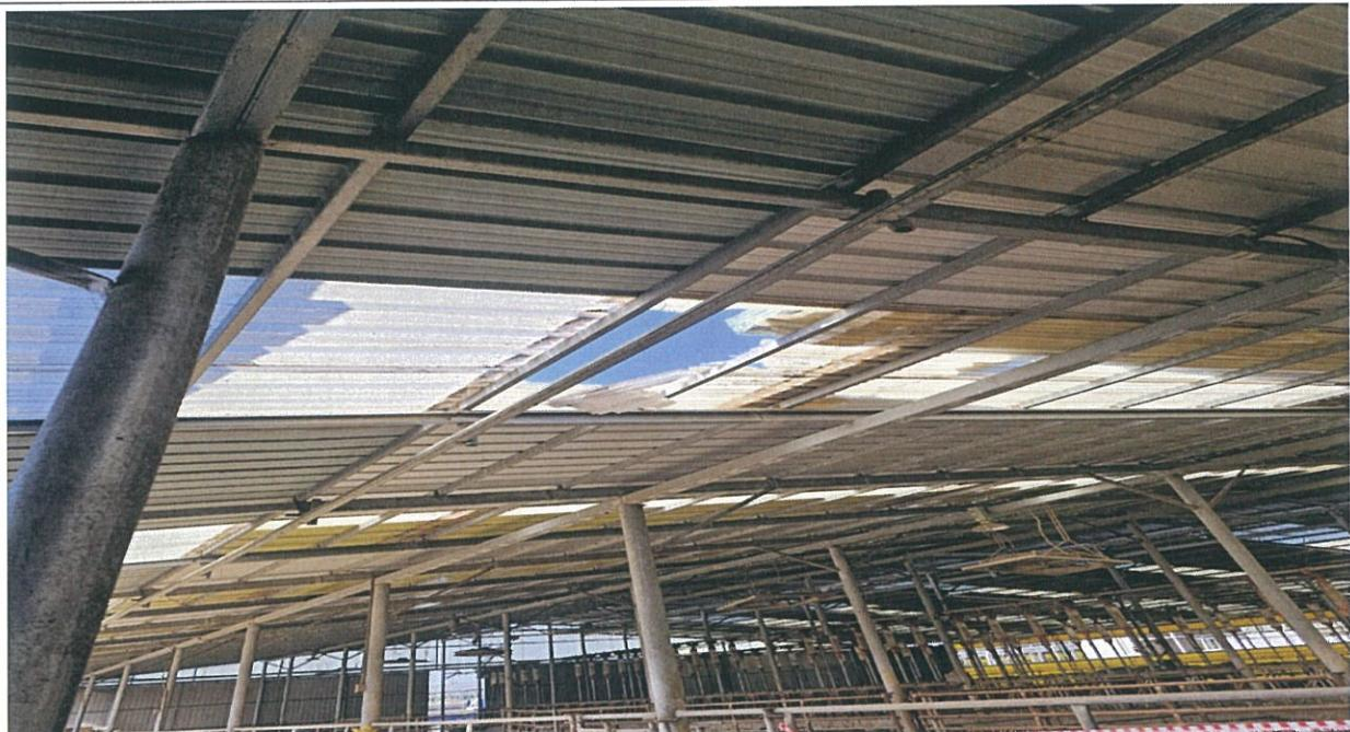
사진 설명 : 지붕 위 작업 시 채광창 덮개, 작업발판, 안전난간, 안전대 결이시설 설치 필요
